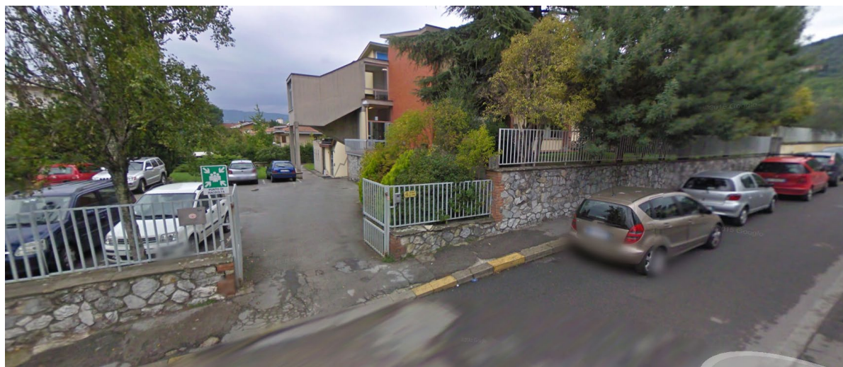
Accesso carrabile da Via G. Galilei: è una delle uscite di sicurezza in caso di emergenza
