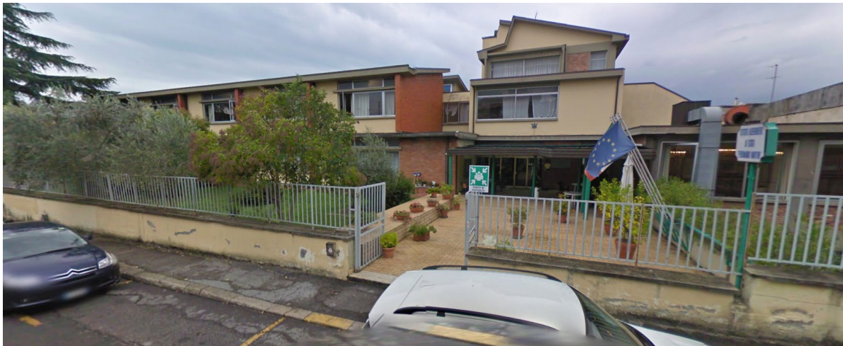
Accesso principale da Via G. Galilei: è una delle uscite di sicurezza in caso di emergenza
